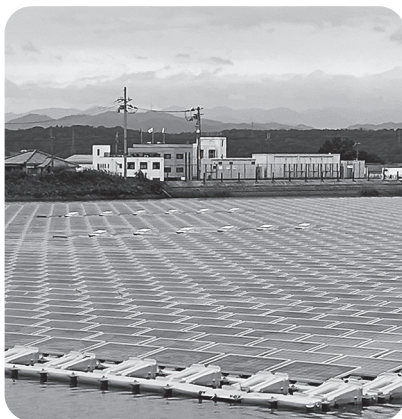
▲パネルを水面に浮かべた平池水上太陽光発電所
