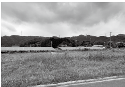
▲音羽電力(株)ソーラーシェアリング1号機建設予定地
